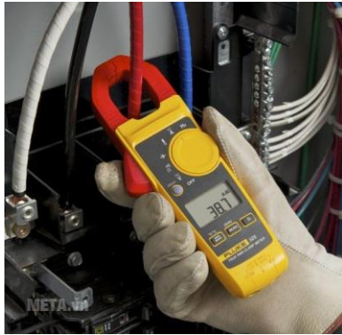
Dùng ampe kìm để đo dòng từng pha
