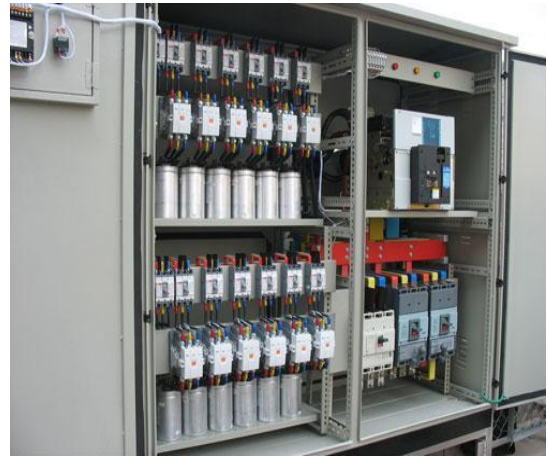
Tủ tụ bù dùng để bù cosφ tự động
