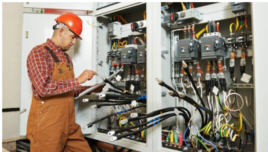
Kỹ sư đang lắp đặt sửa chữa hệ thống điện
