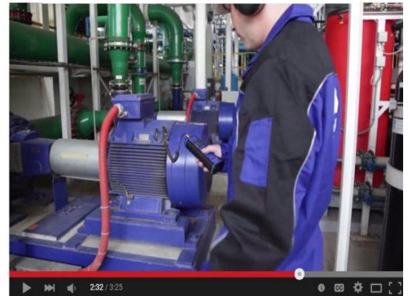
Kỹ sư đang kiểm tra rung động máy bơm
